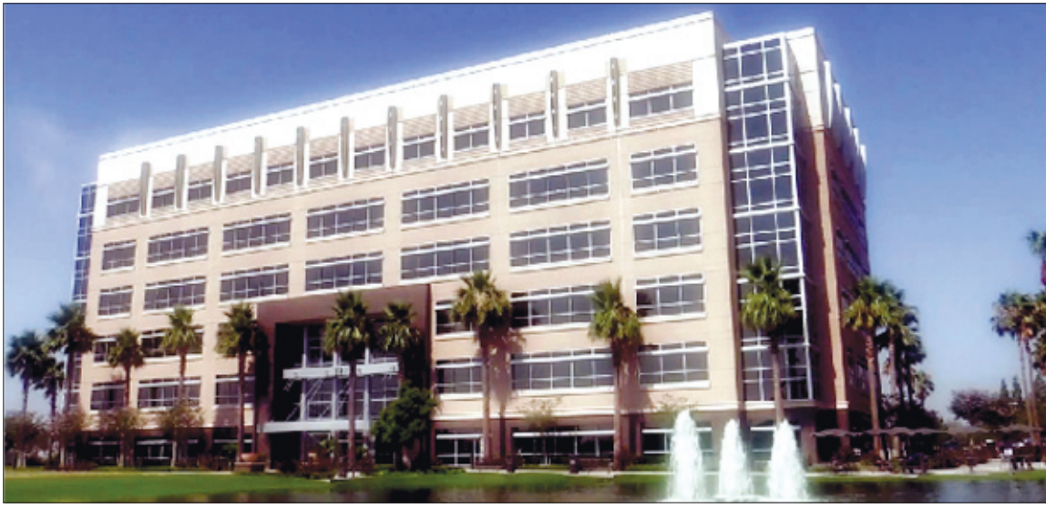
골든게이트침례신학교가 이전하게 될 남가주 온타리오에 위치한 새 캠퍼스 내 건물 ©ggbts.edu
